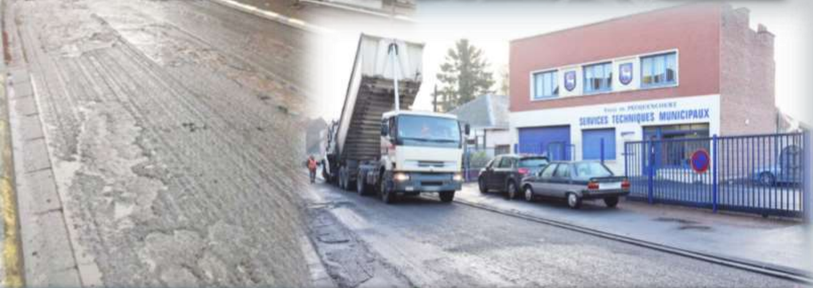
La pluie n'a pas empêché de terminer les enrobés du centre ville, ni ceux des rue du Beffroi et Joseph Bouliez
